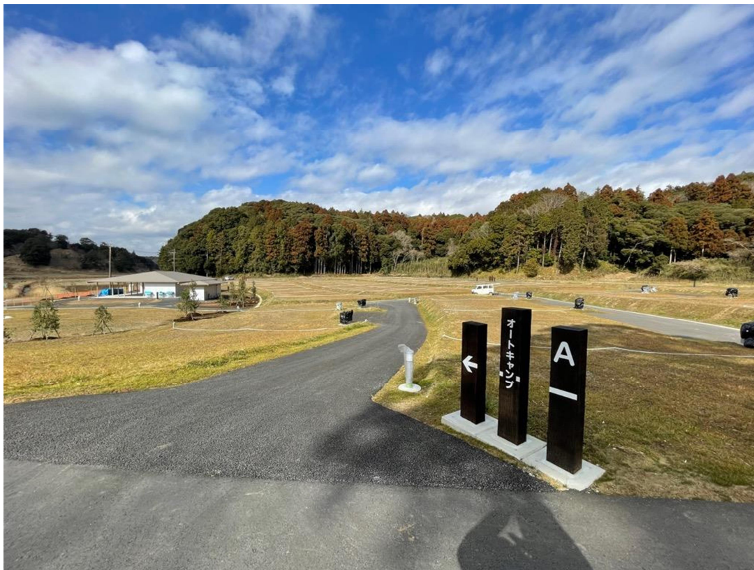
工事進捗状況（2月中旬撮影）
