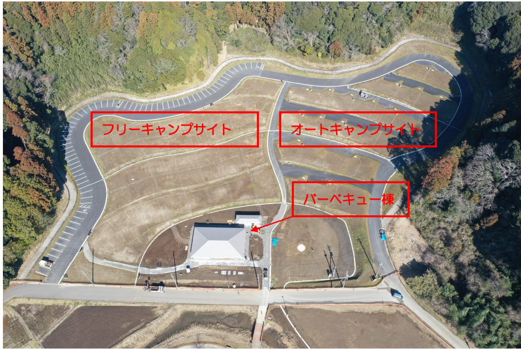
工事進捗状況（1月末撮影）
