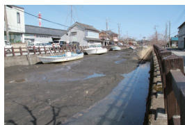
東日本大震災の被害（小野川）
