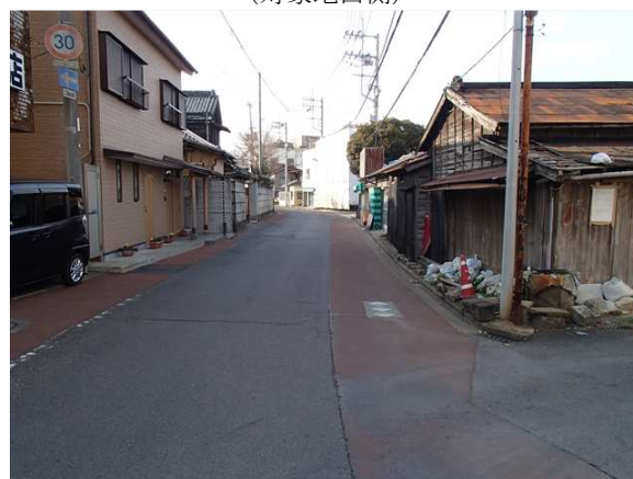
④対象地周辺の状況 (対象地南側)
