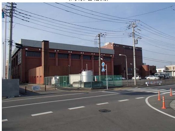
⑪対象地周辺の状況 (佐原文化会館)
