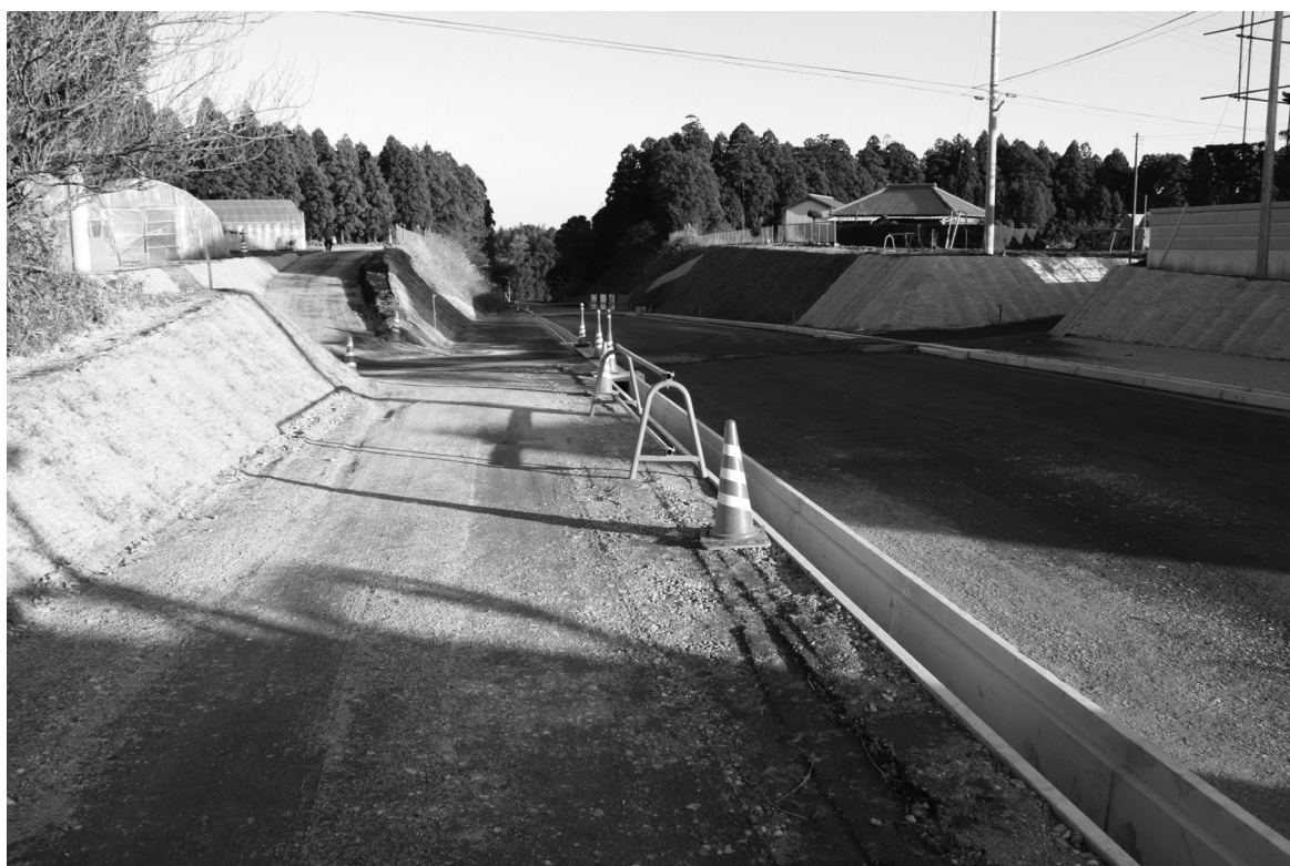
建設中の道路（成田小見川鹿島港線）
