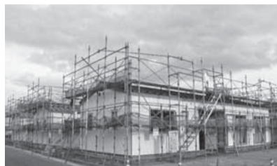
建設中の災害公営住宅
