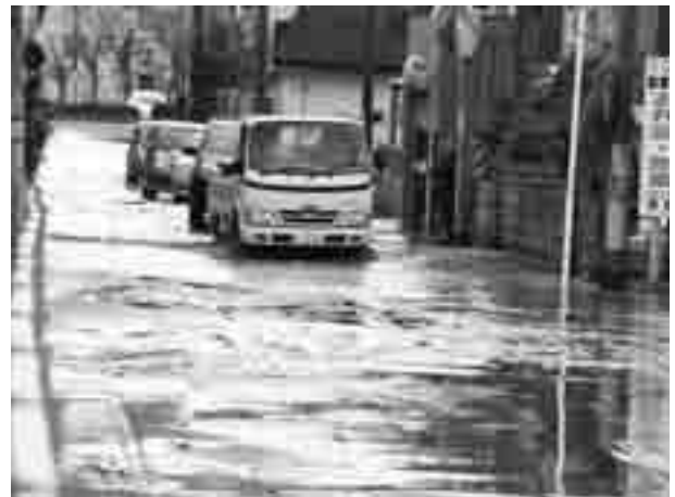
▲液状化により泥水が噴出した道路(水郷町)
