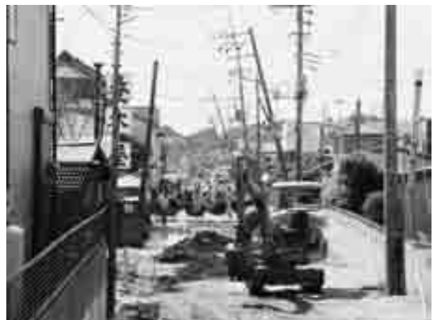
▲道路の復旧工事(粉名口)
