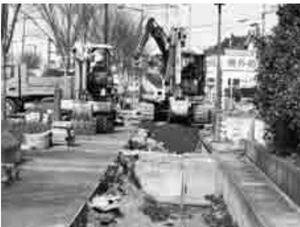
▲下水道の応急復旧(仁井宿)
