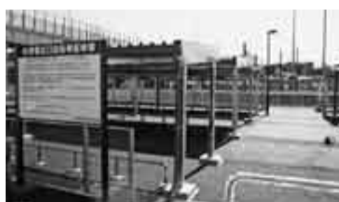
▲完成した佐原駅北口駐輪場
