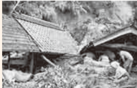
▲昭和46年に発生したがけ崩れで倒壊した家屋
