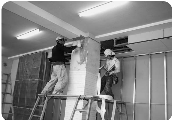
佐原中学校校舎耐震補強工事(SRF工法)
