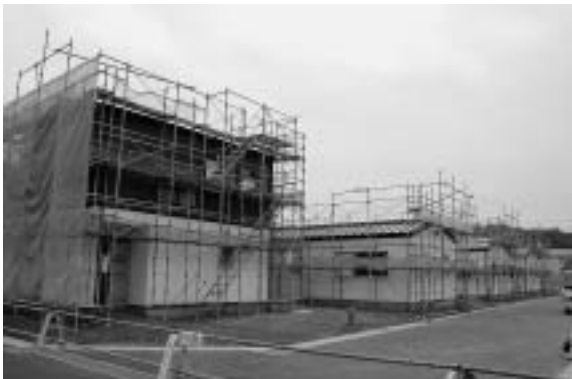
建設中の災害公営住宅(岩ヶ崎地区)
