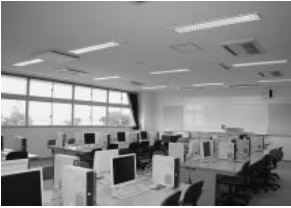
エアコンが設置されている新島中学校のコンピューター室
