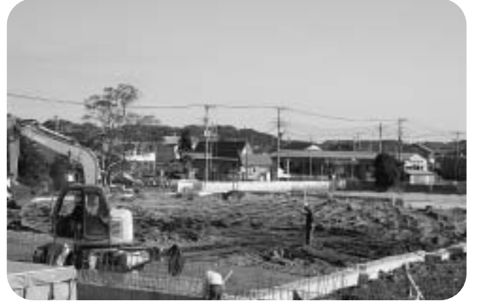
工事中の旧ソニー小見川跡地
