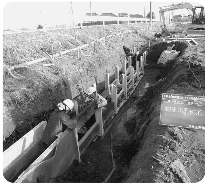
石納・野間谷原地区の災害水田復旧工事
