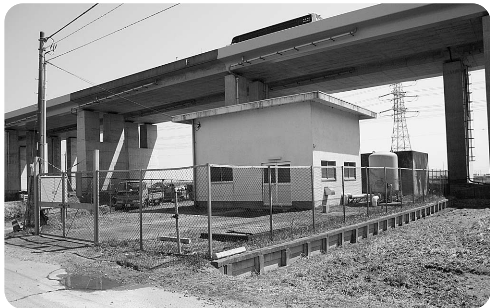
今後、自家発電設備が設置される側高ポンプ場
