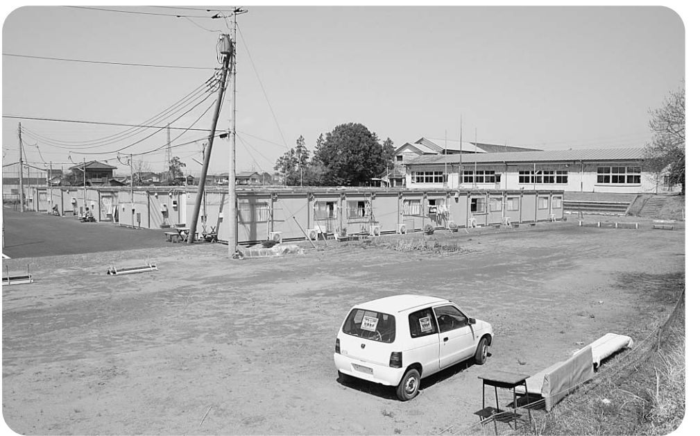
東日本大震災の被災者仮設住宅として活用されている旧佐原第二中学校校庭
