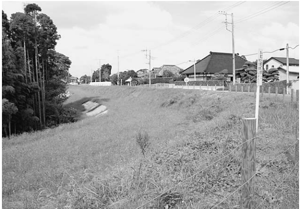
事業中の市道I-57号線道路改良(山田区小川)
