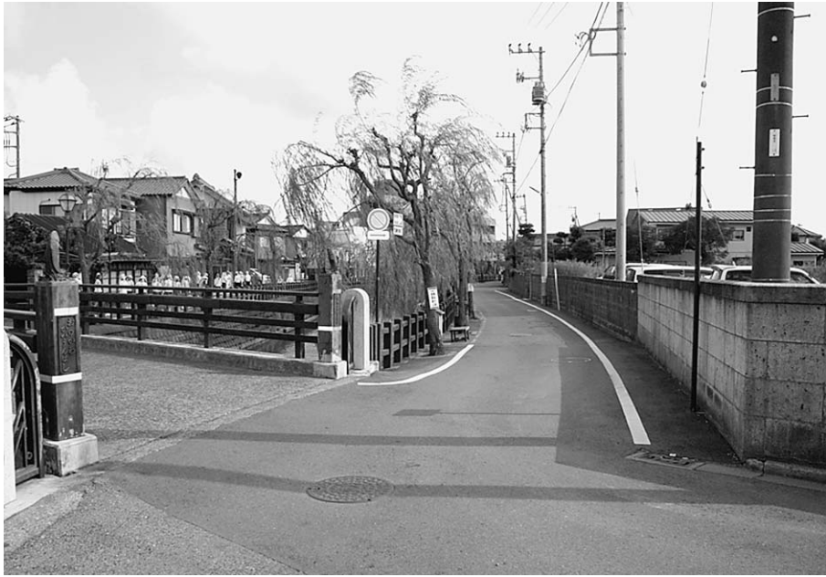
今後、水道老朽管の布設替え工事を行う 小野川左岸の開運橋付近
