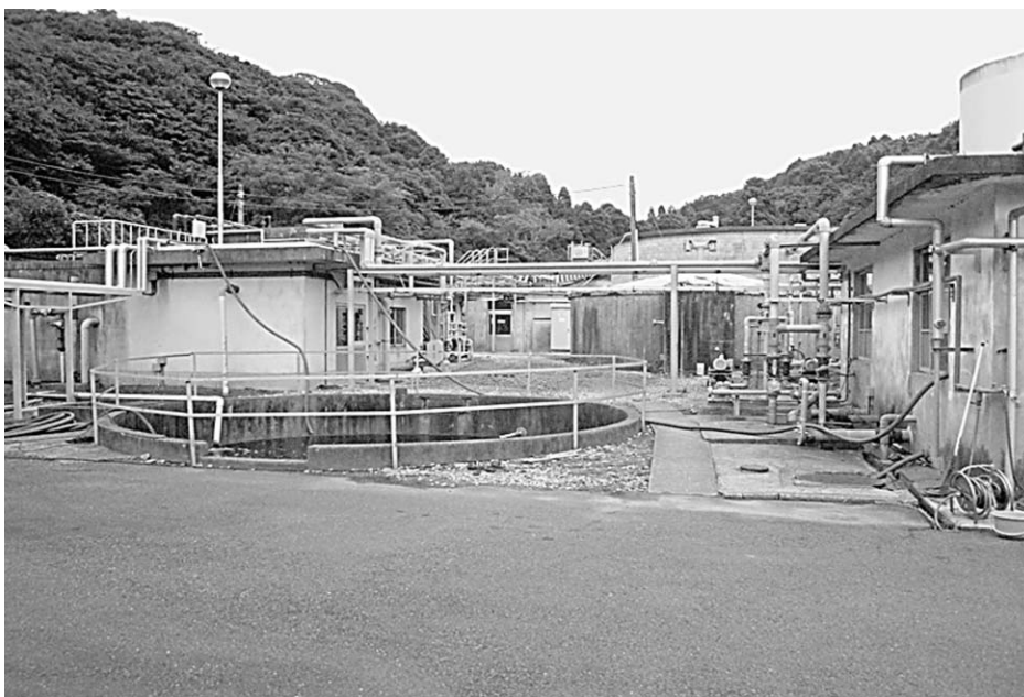
下飯田し尿処理場(小見川区下飯田)
