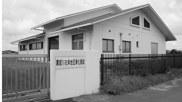
黒部川右岸地区浄化施設(山田区川上)
