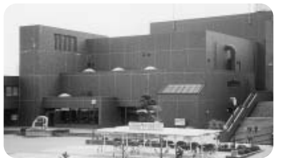
耐震診断を終了した佐原文化会館
