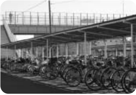
佐原駅北口駐輪場（平成20年度整備予定）
