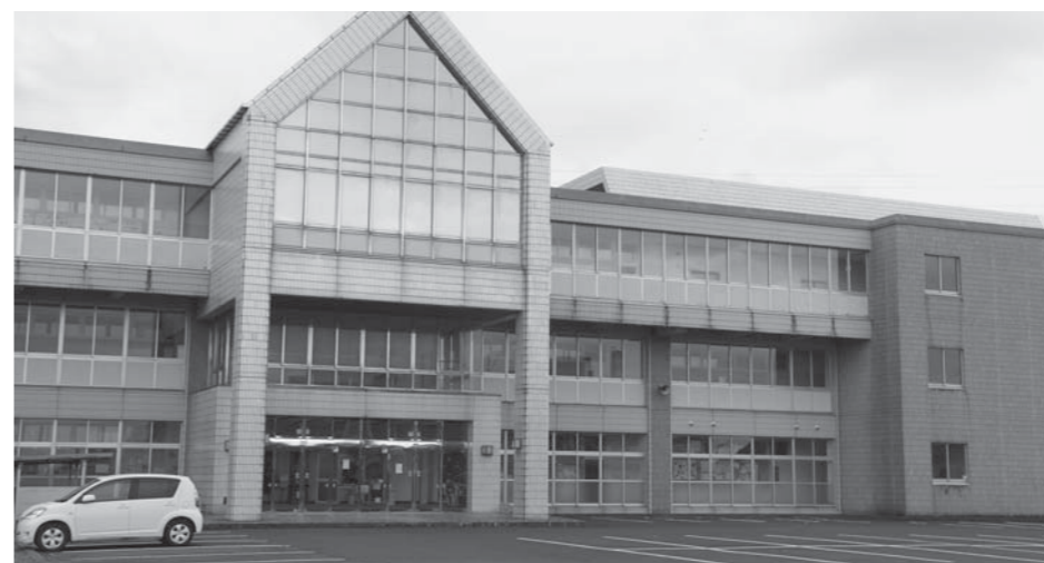
大規模改修が必要とされている校舎
