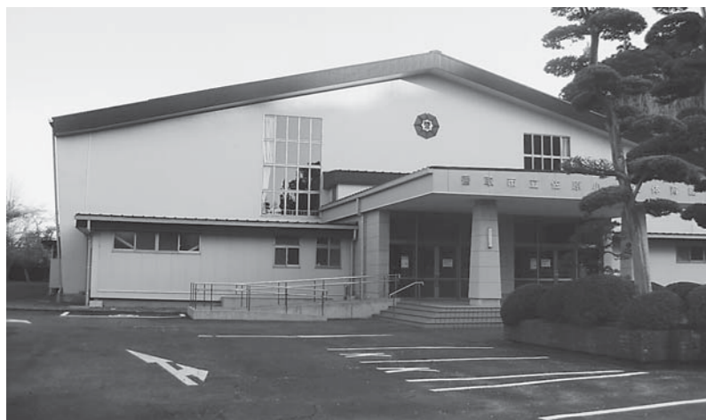
標高5.8m(Y.P.※水位6.62m)、収容人員390人の佐原小学校体育館 ※江戸川工事基準面
