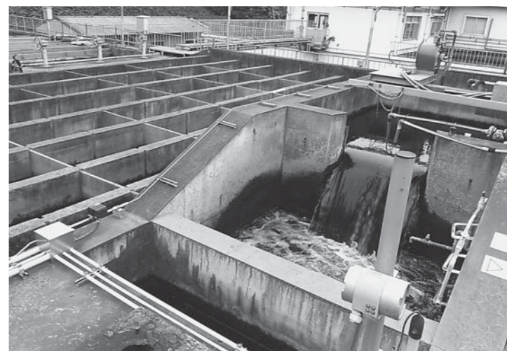
城山第2浄水場浄水施設
