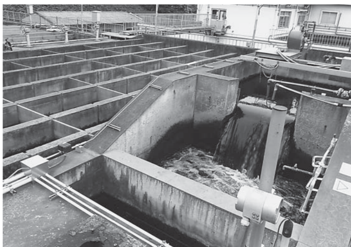
城山第2浄水場浄水施設
