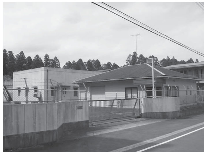
栗源地区簡易水道大畑浄水場
