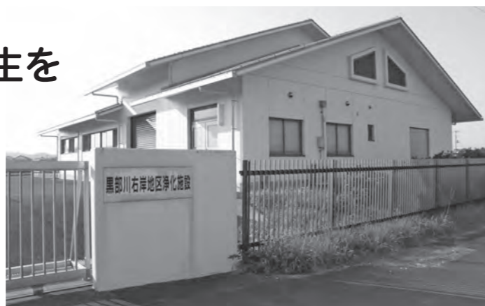
山田の黒部川右岸地区農業集落排水処理施設
