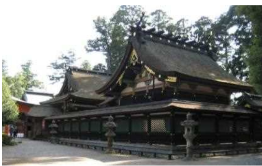
3-5 東国の守護漆黒の本殿 (重要文化財 香取神宮本殿)
