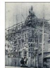
建設中の旧川崎銀行
