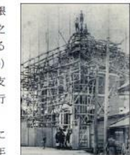
建設中の旧川崎銀行
