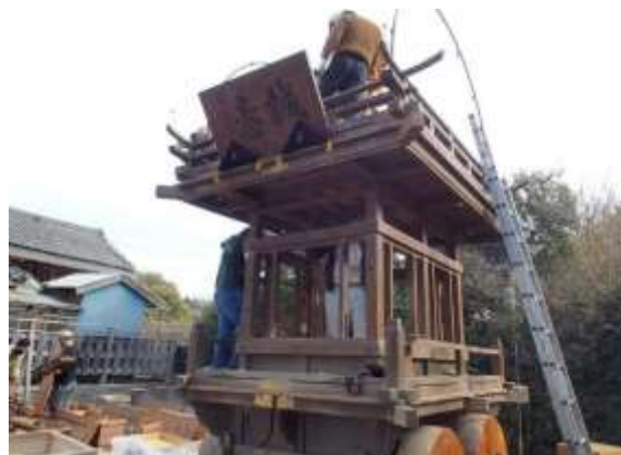
山車実測調査風景
