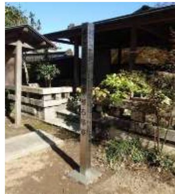
市指定文化財の既存標柱撤去・新設
