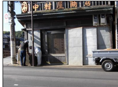
既存雨戸の復旧
