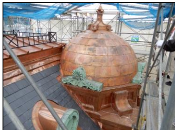
屋根スレート復元・ドーム屋根銅板修復工事
