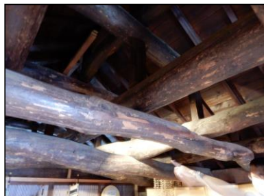
土蔵小屋組み確認
