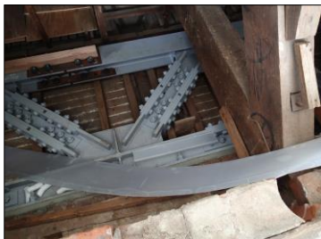
天上上部鉄骨補強工事
