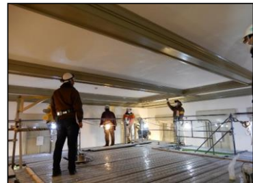
天上漆喰塗替え工事
