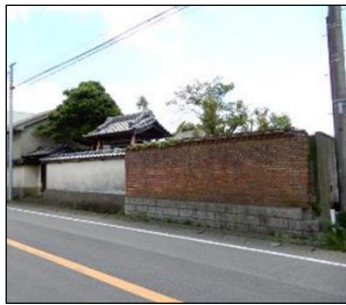
ちば醤油・旧本社煉瓦塀
