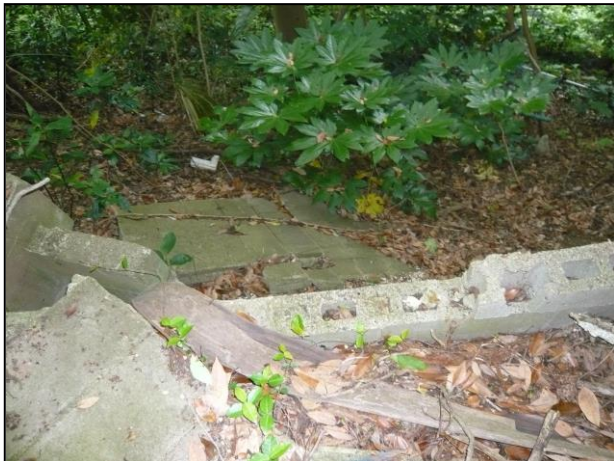
○崩落している土留め
