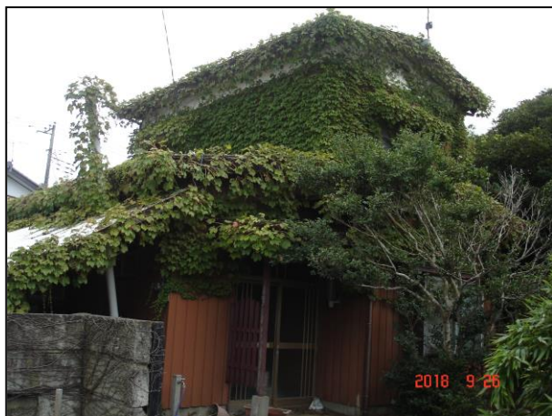
○建物写真（居宅）
