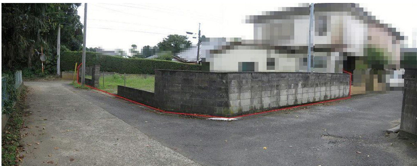
宅地部分の北西側から全体を撮影
