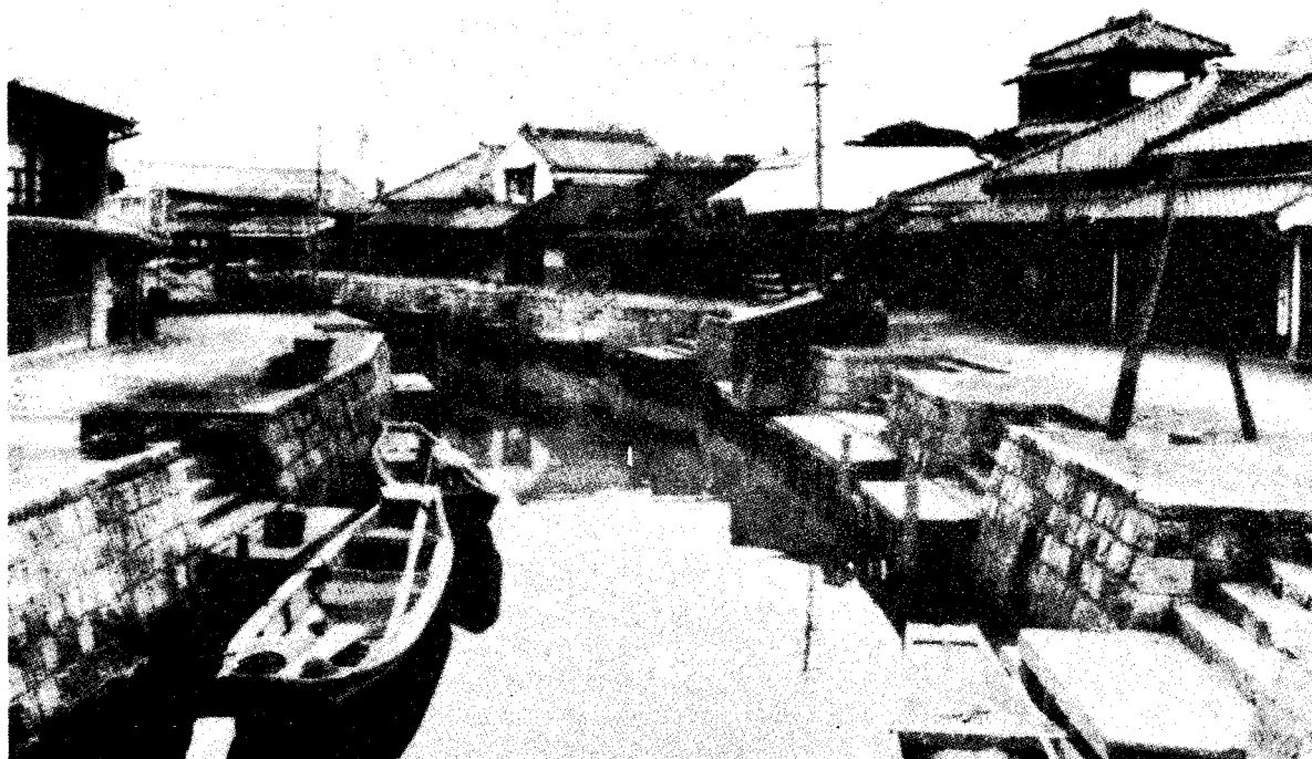
●昭和10年下川岸付近のだし、護岸擁壁工事竣工記念の写真。「ふるさとの思い出写真集」より
