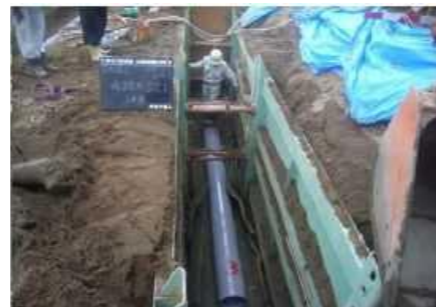
写真-6 暗渠排水管の布設状況
