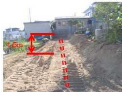
写真-5 暗渠管布設位置
