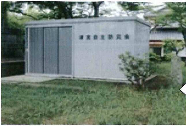
水の郷小 隣接地に設置の防災倉庫
