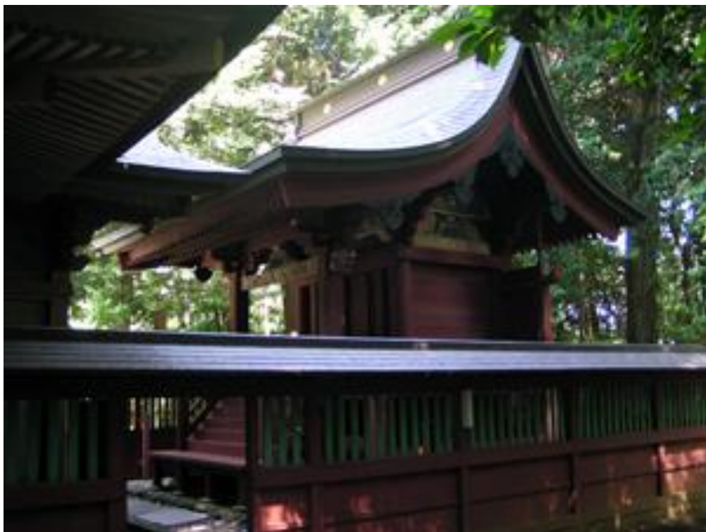
【千葉県指定文化財】側高神社本殿（独自の構造を持つ本殿）
