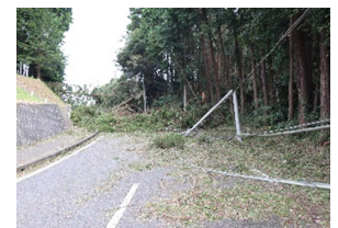
台風 15 号による被害
