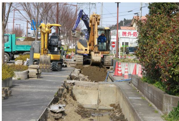
下水道の応急復旧(仁井宿)
