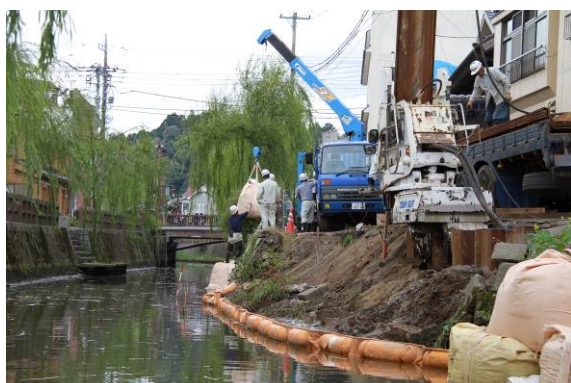
小野川護岸の復旧工事
