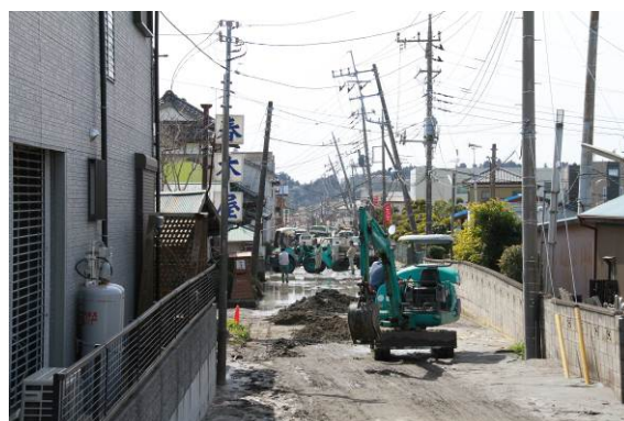
道路の復旧工事
