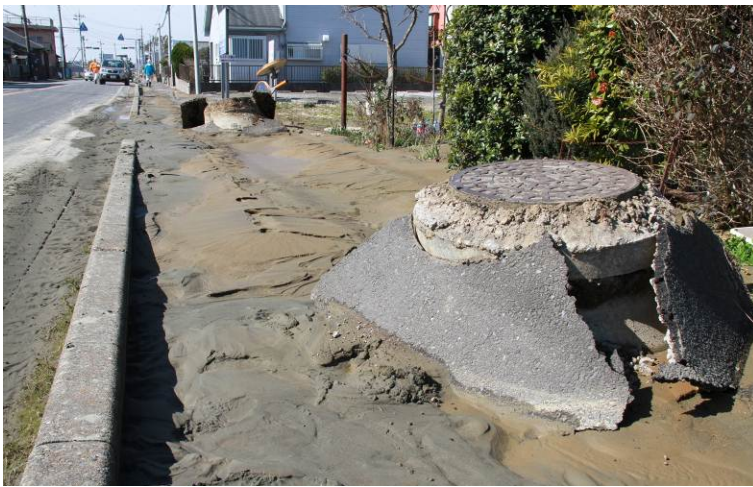
隆起したマンホール(新開町)
