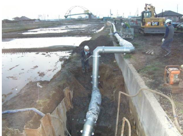
水道の応急復旧(荒川)
