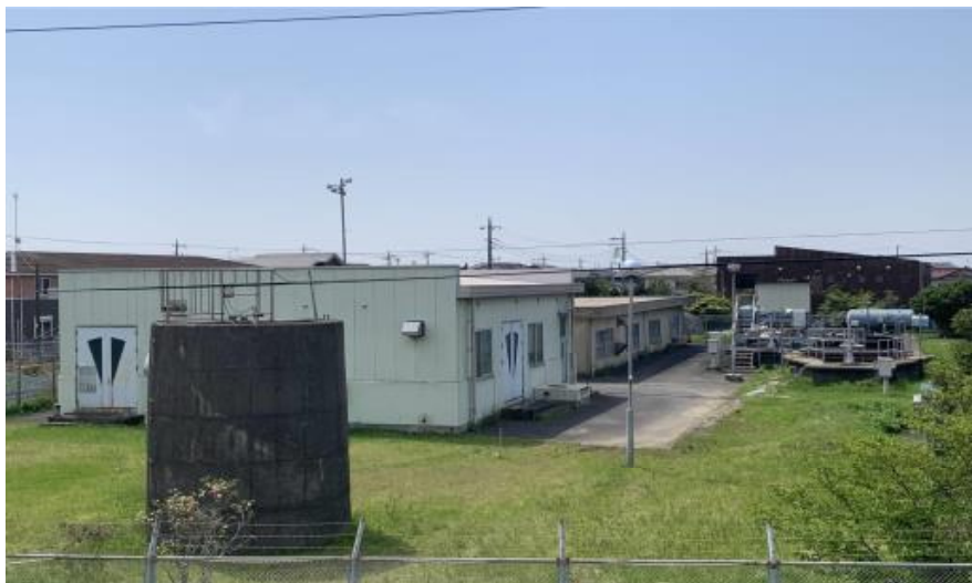
利 根 川 取 水 場
