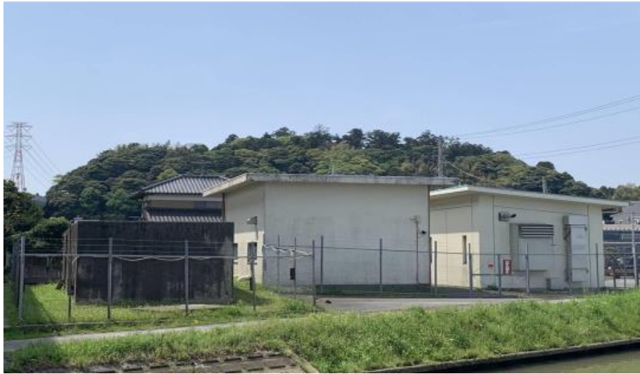
側高配水ポンプ所
