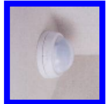
空間センサー (天井付) 1台
