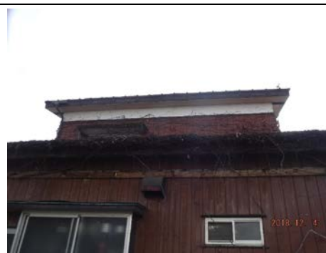
破損軒天養生
