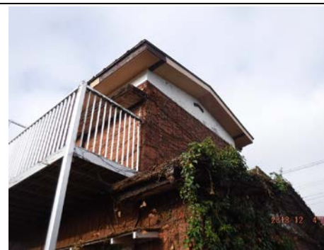
破損軒天養生
