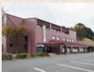
栗源支所 (栗源市民センター「さつき館」)
