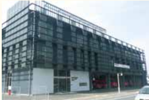
消防本部・佐原消防署の新庁舎
