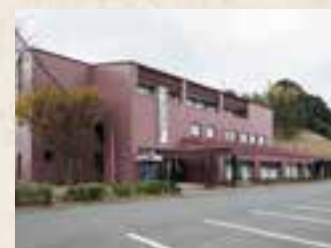
栗源支所 (栗源市民センター「さつき館」)
