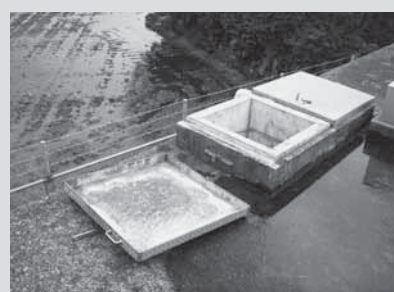
▲南京錠が壊されていた配水池
