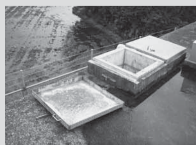
▲南京錠が壊されていた配水池
