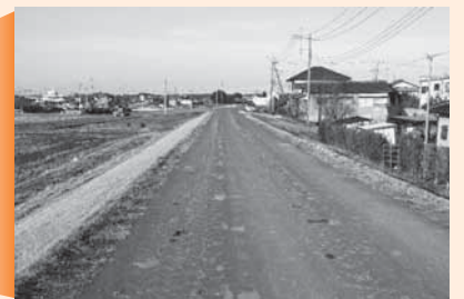
復旧工事が完了し、通行可能に
