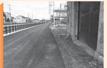
復旧工事が完了
