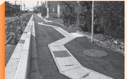
3月末で復旧工事が完了予定
