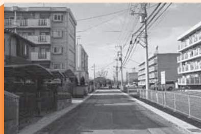
復旧工事が完了
