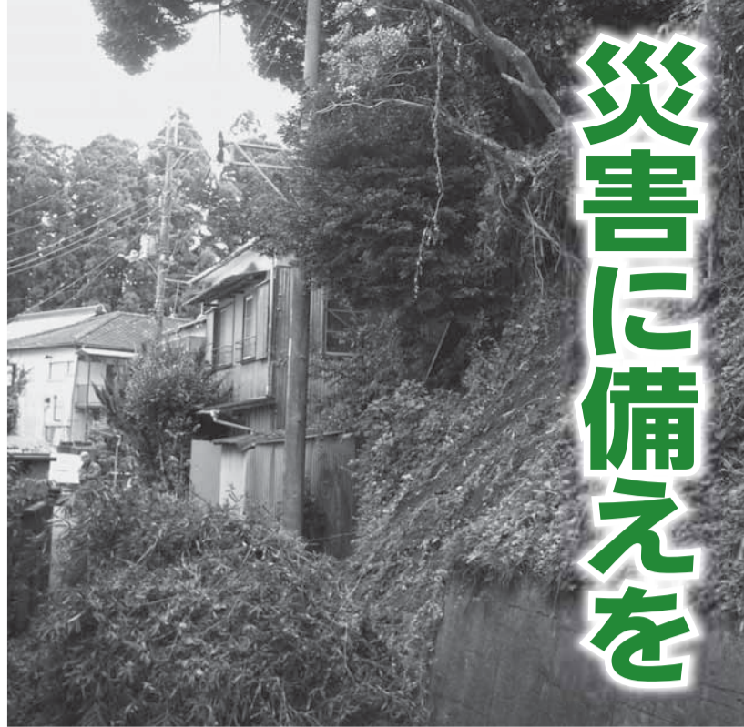
▲平成19年、台風20号によるがけ崩れ（平台地区）
