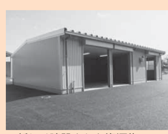
▲新しく建設された資源物ストックヤード
