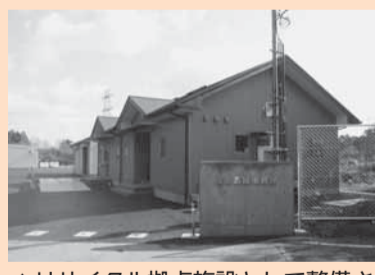
▲リサイクル拠点施設として整備された佐原清掃事務所
