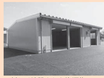
▲新しく建設された資源物ストックヤード
