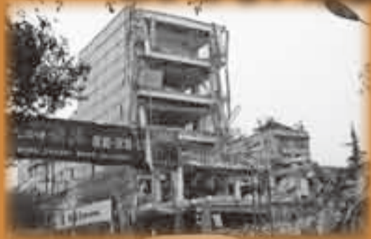
▲中国四川大地震で崩れたビル
