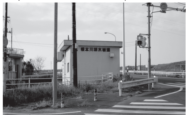
▲根本川排水機場(津宮)
