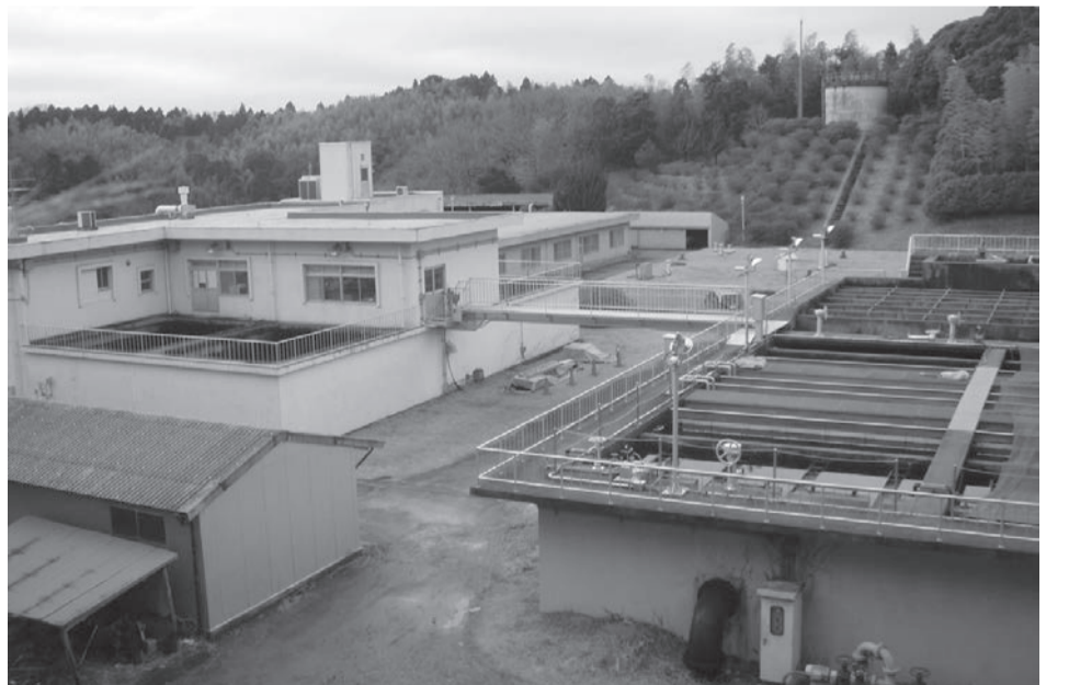
▲小見川浄水場 (小見川)
