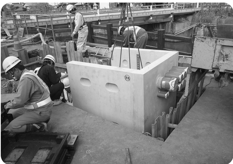
小野川左岸電線共同溝工事(佐原イ)
