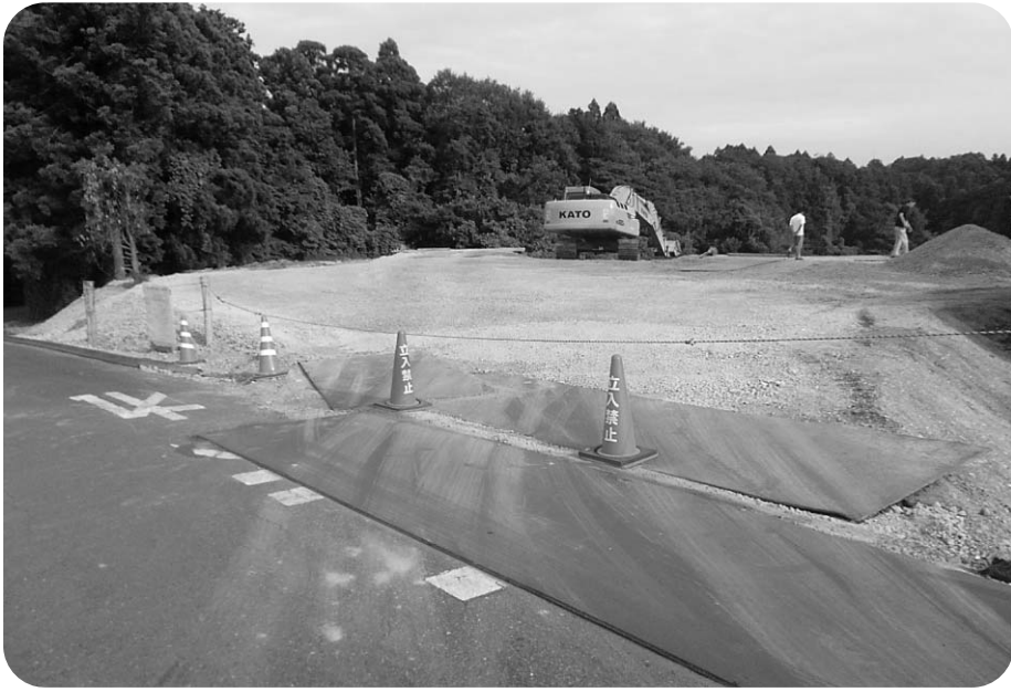
桐谷太陽光発電所建設に伴う埋め立て事業場(桐谷)
