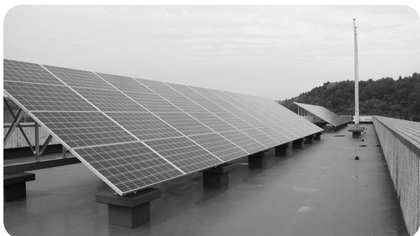
小見川西小学校屋上の太陽光発電施設
