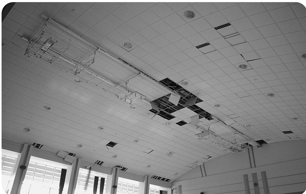
震災で天井が剥がれ落ちた栗源中体育館
