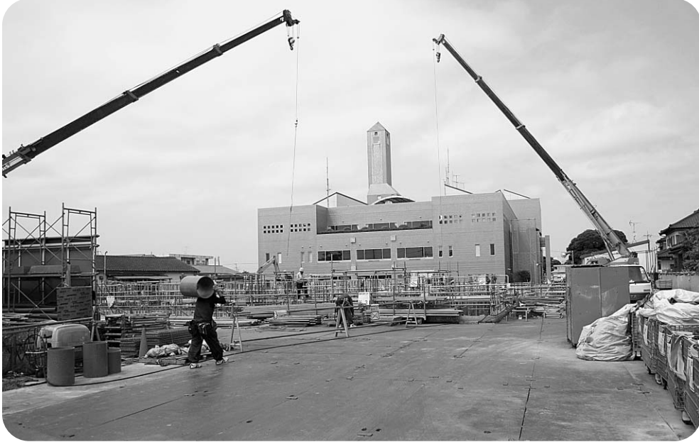
現在、建設中の(仮称)小見川市民センター
