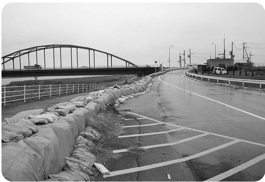
震災後の利根川右岸堤防
